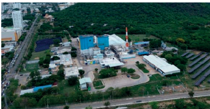
Unergy S.A.S. E.S.P. Generación Distribuida 5 proyectos 1 MW
