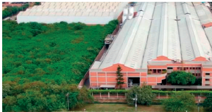
Plásticos Rimax S.A.S. Autogeneración Solar Planta de producción
